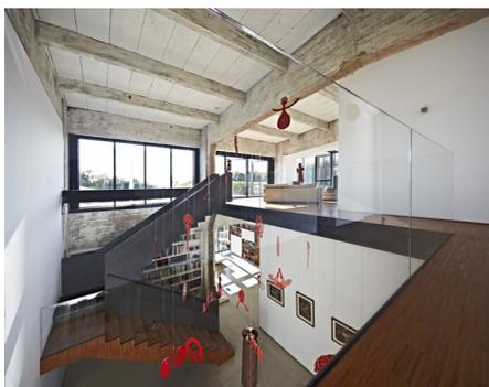
*Betonrahmen, je zwölf Meter tief und 8,50 Meter hoch, überspannen die Halle. Durch die räumliche Wirkung und das industrielle Flair entstanden helle und luftige Wohnungen.*
